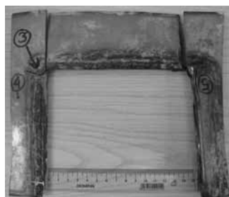
Rys. 3. Próbkę pobrane z wycięcia w płaszczu grzewczym na nogi zbiornika – widok elementów z pęknięciami w spoinach narożnych
