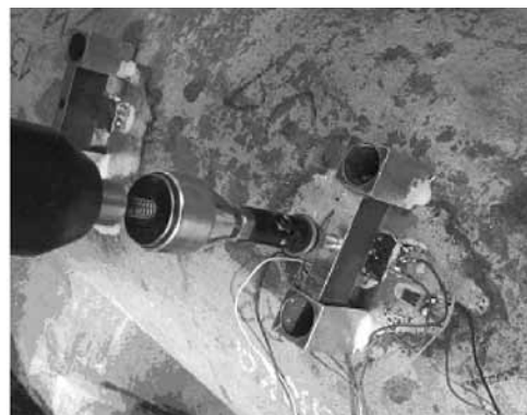
Rys. 3. Instalacja tensometryczna na rurociągu, wykonanie odwiertu odprężającego
