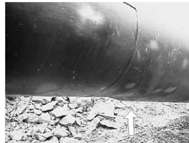
Rys. 8. Fragment badanego rurociągu
