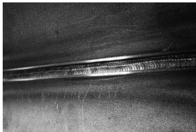
Rys. 2. Wygląd złącza spawanego z wyfrezowanymi rowkami Fig. 2. Appearance of the welded joint with milled grooves
