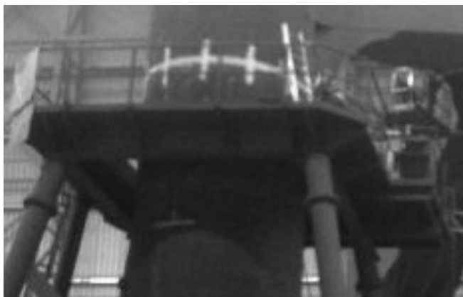
Rys. 5. Proces kontroli niezgodności powierzchniowych Fig. 5. Process control welding imperfection on the surface
