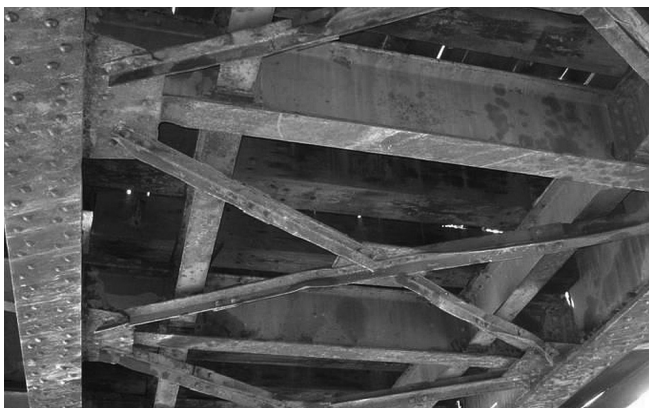
Rys. 2. Konstrukcja przęsła przed naprawą Fig. 2. The span before refurbishment
