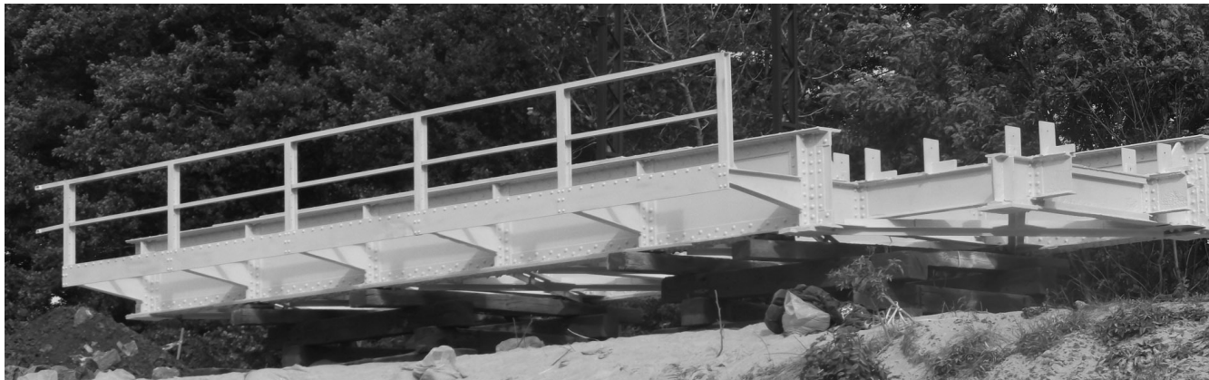
Rys. 8. Ogólny widok ukośnego przęsła wiaduktu w końcowej fazie naprawy i wzmocnienia Fig. 8. The strengthening of: a) the plate girder, b) the end cross beam
