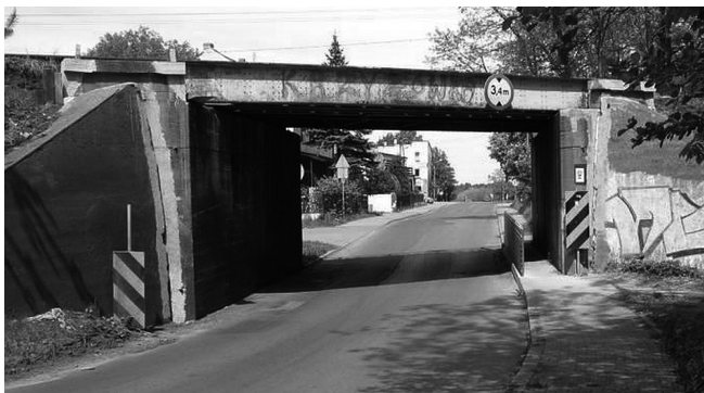
Rys. 1. Widok ogólny wiaduktu Fig. 1. General view of the viaduct
