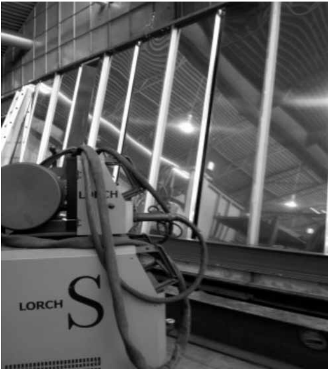
Rys. 4. Zasadnicza część filtra podczas montażu przy zastosowaniu metody SpeedRoot
