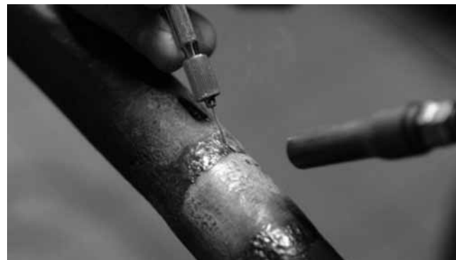
Rys. 4. Strefa spawania laserowego warstwy licowej złącza doczołowego rury napisu
