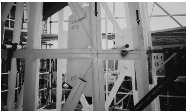
Rys. 4. Spoiny czołowe prętów krawężnikowych styku montażowego Fig. 4. Assembly edge-rod butt welds
