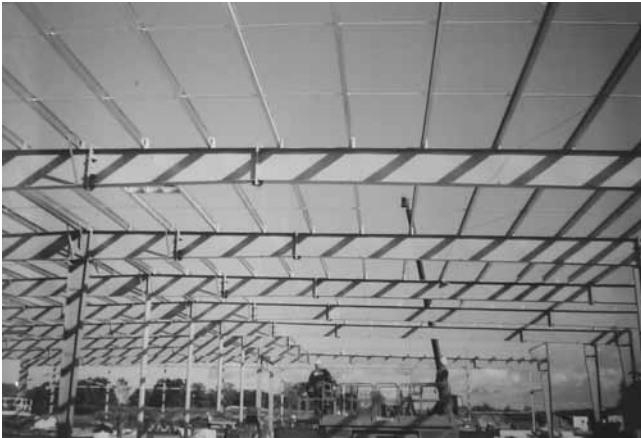
Rys. 6. Widok ogólny stalowej konstrukcji hali produkcyjnej Fig. 6. The main view of hall steel construction
