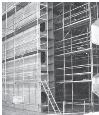
Rys. 12. Połączenie grodzi wzdłużnej-koferdamowej (GWK) do dna wewnętrznego (DW), gdzie: 1 – gródz wzdłużna-koferdamowa (GWK), 2 – dno wewnętrzne (DW)
