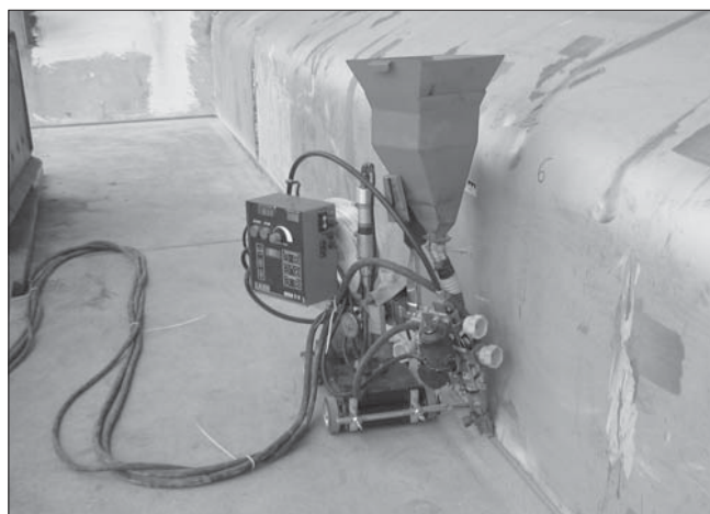
Rys. 11. Automatyczne spawanie warstw wypełniających z obu stron złącza metodą SAW
