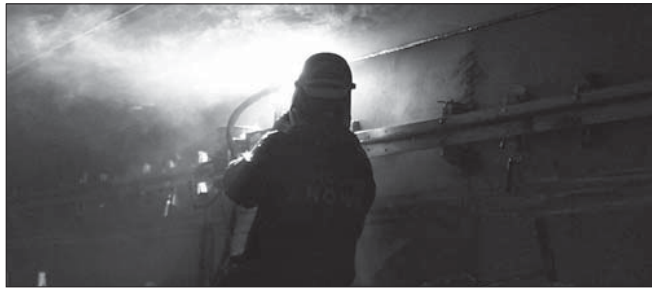
Rys. 21. Spawanie warstw wypełniających w sposób zmechanizowany automatem Bugo-matic
