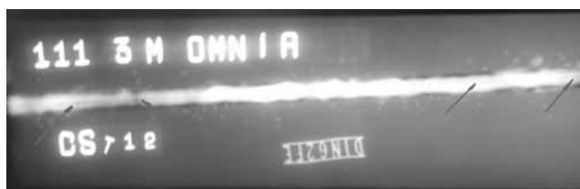
Rys. 7. Radiogram złącza spawanego 12/111/PA, widoczne niezgodności spawalnicze typu żużle lub brak przetopu na całej długości próbki (wskazane strzałkami) [11]
