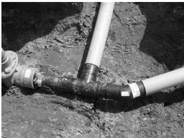
Rys. 9. Odgałęzienie trójnikowe z zasuwą odcinającą Fig. 9. Tee branch with a blocking bolt
