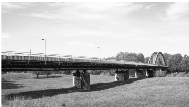
Rys. 2. Widok ogólny 5 przęseł mostowych Fig. 2. General view of 5 bridge plate girders
