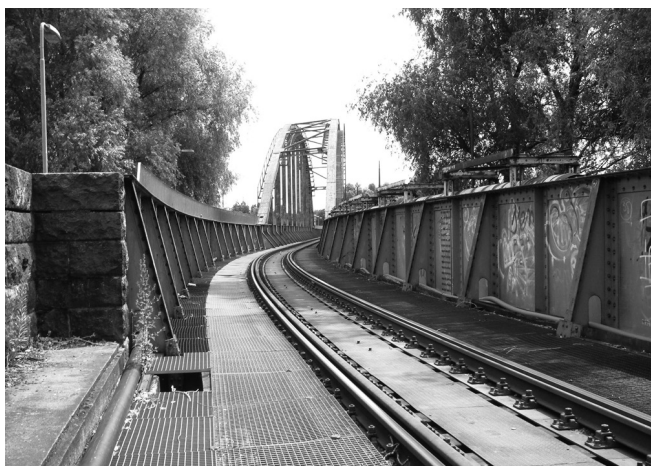
Rys. 3. Jezdnia mostowa Fig. 3. Bridge deck
