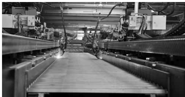
Rys. 9. Proces spawania dwuteownika ze środkiem spawanym [7] Fig. 9. Welding process of an I-beam with a welded web [7]
