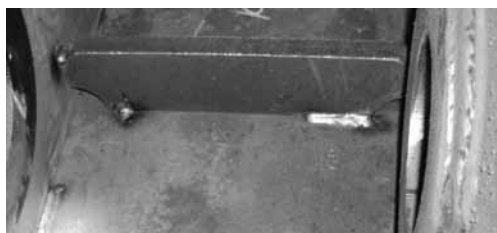
Rys. 9. Spoiny szczepne – lewa strona nieprawidłowa, prawa strona prawidłowa (dł. min. 50 mm) Fig. 9. Positional welds – left side improper, right side – proper (minimum 50 mm long)
