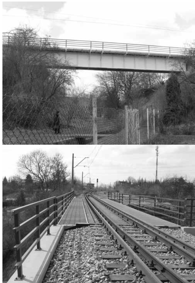
Rys. 1. Widok ogólny mostu i jego nawierzchnia po remoncie Fig. 1. View of bridge and the railway after modernization
