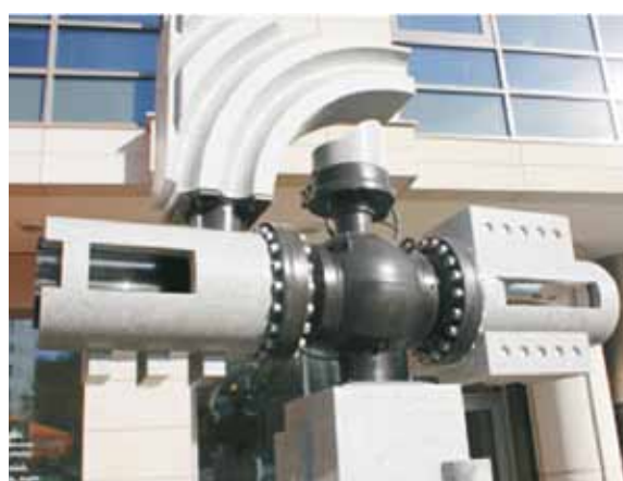
Rys. 14. Zawór gazowy w trakcie natryskiwania ciepłego i fragment pomnika z wkomponowanym zaworem z widoczną czarną malarską warstwą doszczelniającą powłokę NC
